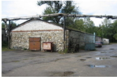
Фото № 1 Склад ГСМ.
